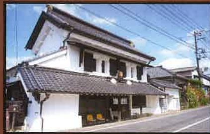
11 釜屋 土蔵造りの商家で質屋・金物屋を営業していた。現在は、建物の内外を自由に見学できる施設となっている。
