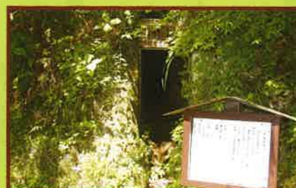
2 大多喜水道跡 千葉県最古の水道施設。江戸時代から計画され1870年(明治3年)に完成した。水路総延長 5,760m
